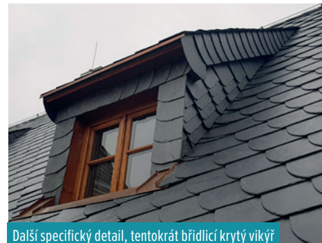
Další specifický detail, tentokrát břídlíci krytý vikýř na střeše objektu celnice v Kutné Hoře.
