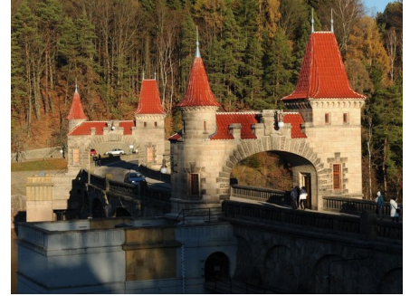
Celkový pohled na obě romantizující průjezdné brány hráze Les Království s novou krytinou Tondach | Foto: Miroslav Vízek | Licence: Všechna práva vyhrazena
