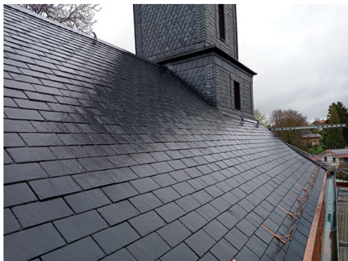
Rekonstrukce střechy a fasády zámku v německém Altenburgu
